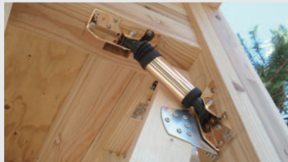
耐力壁の筋交い部に取り付けした「安震くん」
