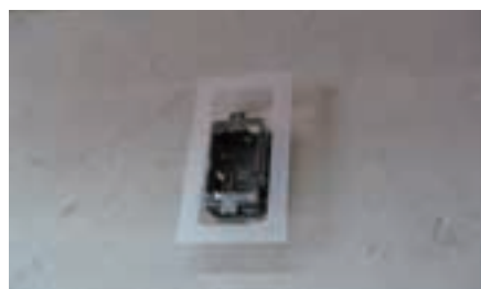
写真 5.5.5 気密コンセントボックスの例
