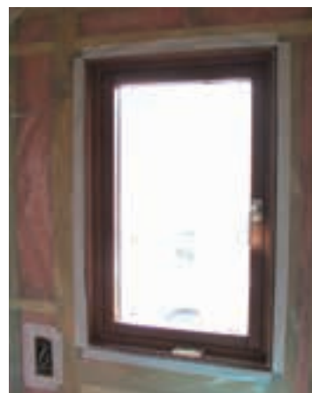
写真 5.6.1 開口部の気密化例
