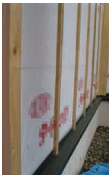
写真 3.2.5 透湿防水シートの施工例
