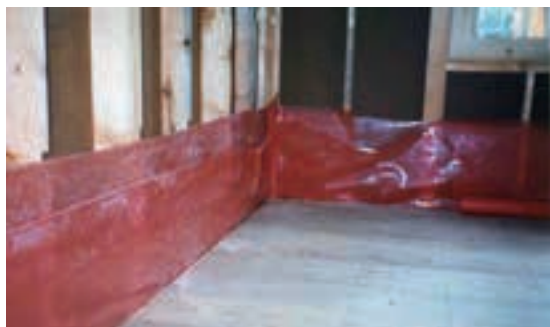
写真 5.2.1 先張り防湿フィルムの施工例
