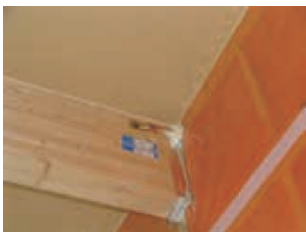
写真 5.5.1 柱下部が防湿フィルムを貫通する部分の施工例
