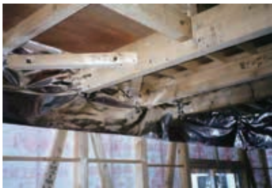
写真 5.2.2 先張り防湿フィルムの施工例 1
