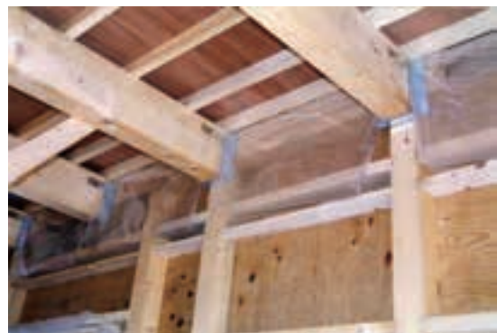
写真 5.2.3 先張り防湿フィルムの施工例 2
