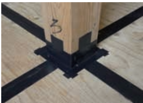
写真 5.5.1 柱下部が防湿フィルムを貫通する部分の施工例
