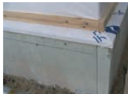
写真 5.1.2 基礎断熱の施工例
