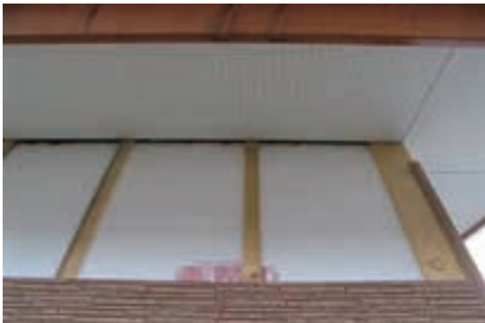
写真 5.1.3 縦胴縁と軒天部の納まり例
