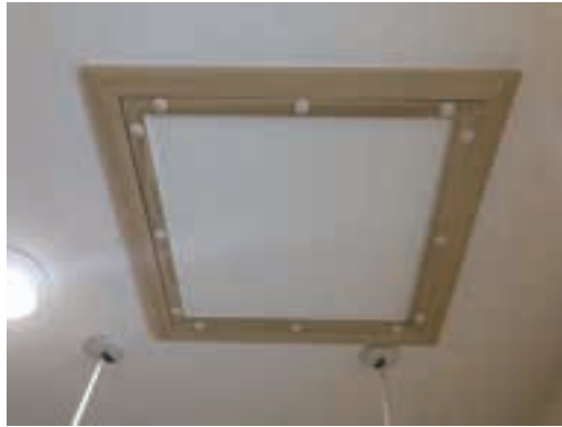
写真 5.5.6 気密点検口による断熱気密化の例
