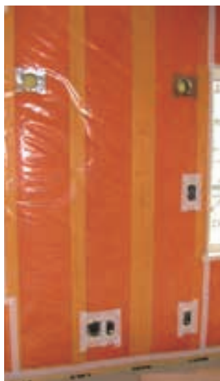
写真 5.5.4 コンセント部などの気密化例
