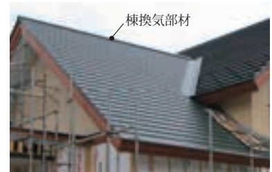
写真 5.1.5 棟換気併用軒天換気方式の例
