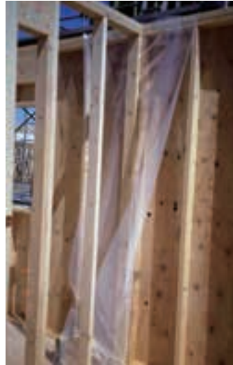
写真 5.4.1 先張り防湿フィルムの施工例
