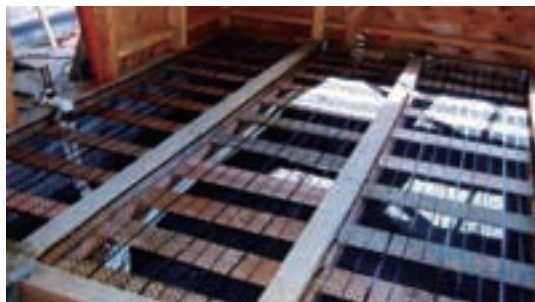
写真 5.1.1 床の断熱材受けの施工例
