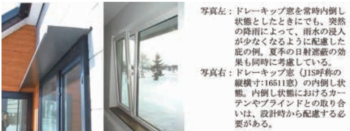
写真 3.3.1 常時開放に適したドレーキップの窓
