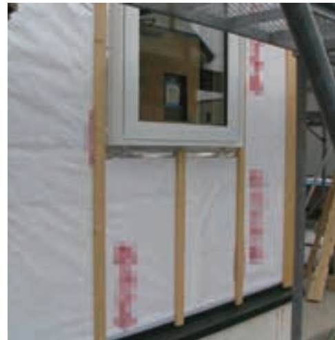
写真 5.1.4 縦胴縁による通気層の施工例
