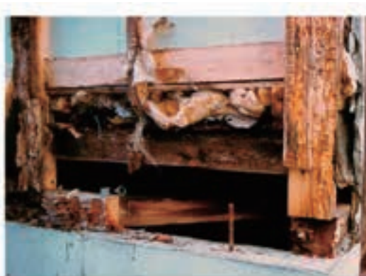
写真 2.1.4 結露被害
