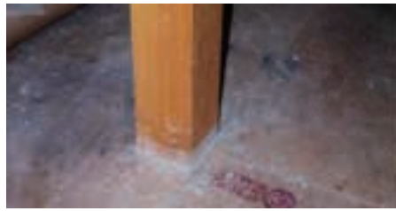
写真 5.1.6 間仕切壁部分の床を先行して施工した例
