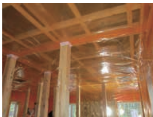
写真 5.2.4 天井の防湿フィルムの施工例
