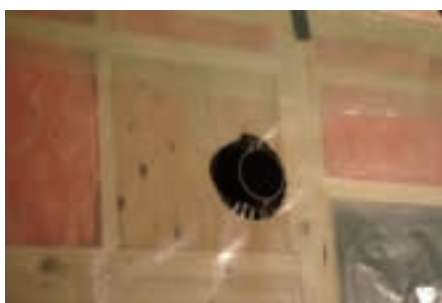
写真 5.5.3 換気孔貫通部の気密化例
